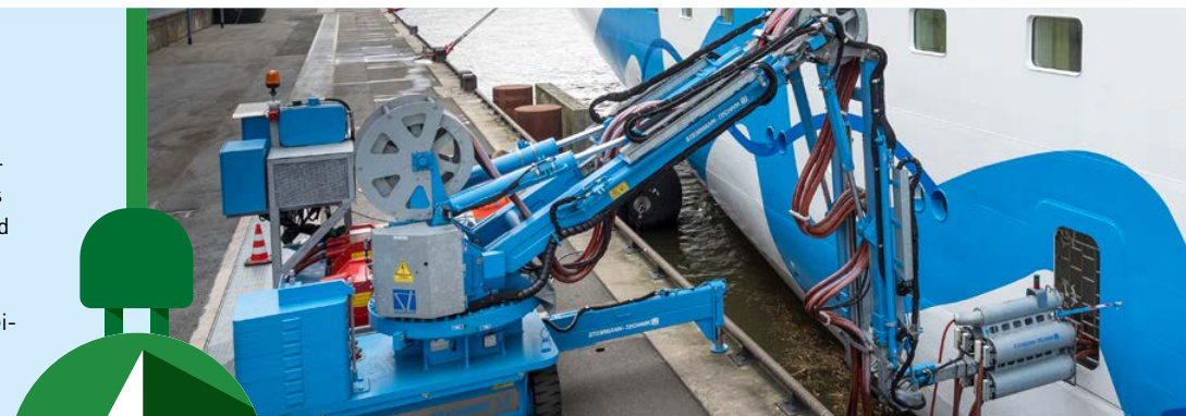
Kreuzfahrtterminal Altona: Landstromversorgung in Hamburg
